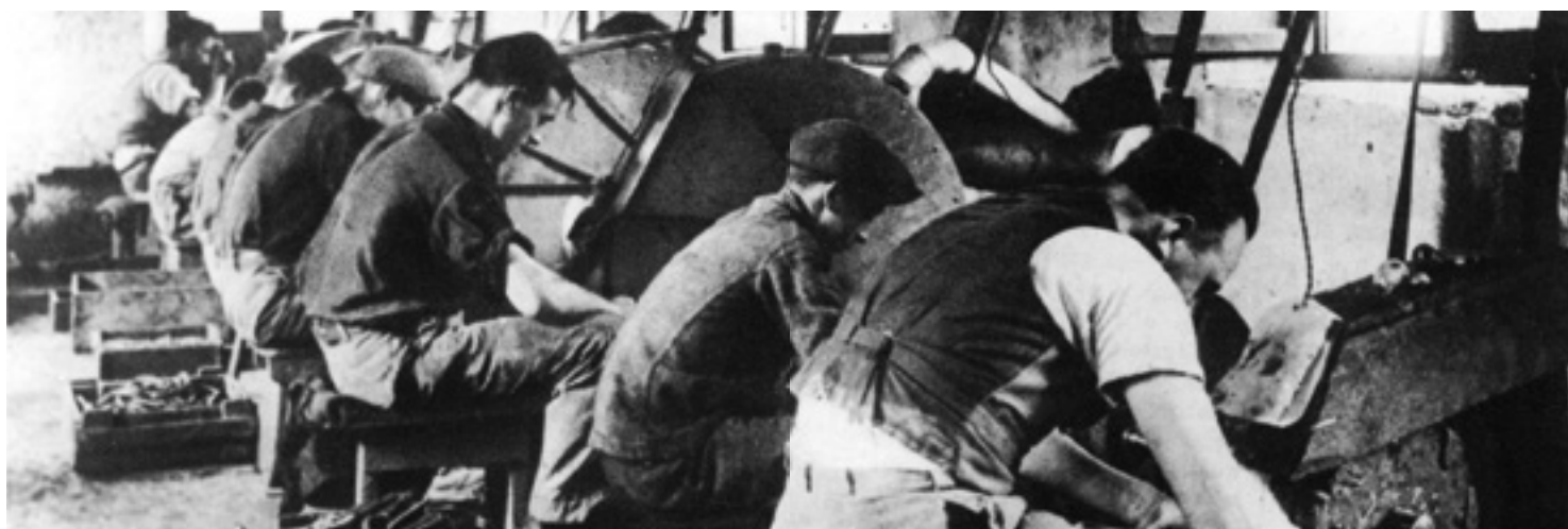
Grinding wheels / Finitura alle mole
